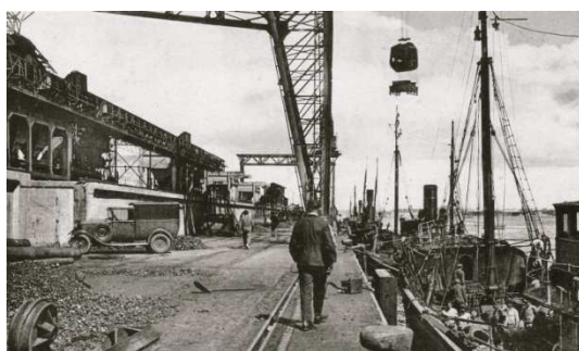
Figure 11 – Le môle à charbon de Keroman
