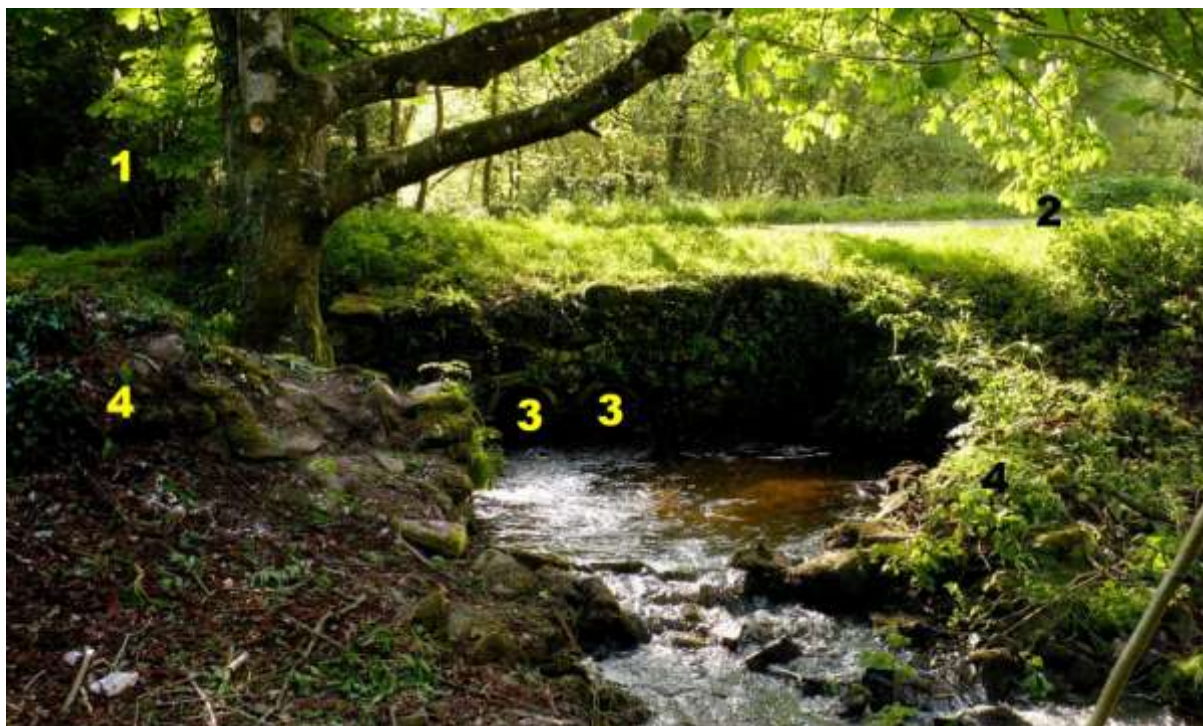
Fig. 6 : Pont Fertil vu côté aval: 1= départ chemin de Kerguillerm. 2 = chemin vers le nord (vers Coatsal). 3 = double buse (montrant que le pont a été remanié récemment, mais il est toujours dans le prolongement du chemin de Coatsal comme sur le cadastre de 1844). 4 = reste de mur de part et d'autre du ruisseau.
