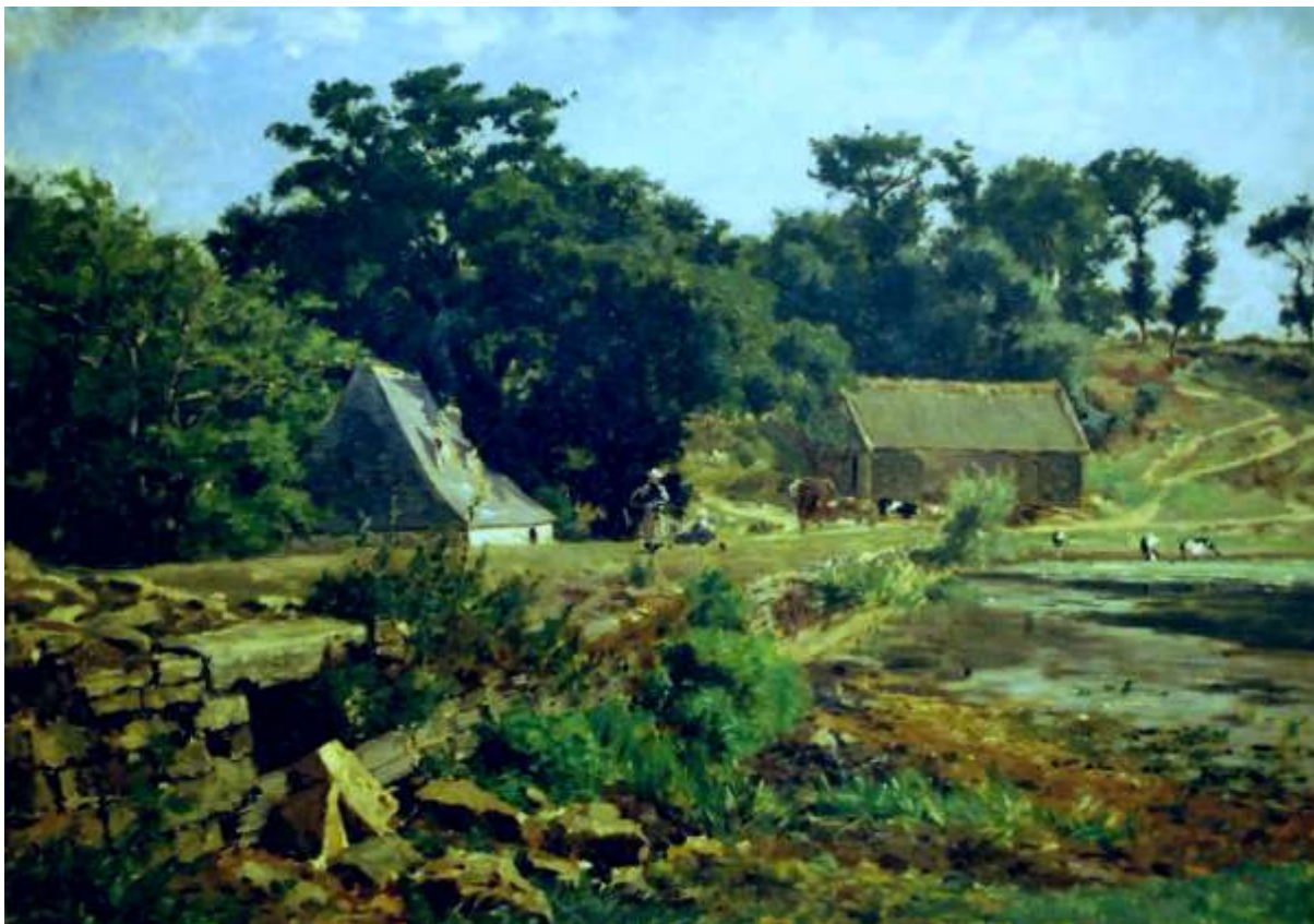
Fig.29 : La seconde chaussée-digue : Tableau du peintre Camille Bernier intitulé « la vanne de l'étang de Quimerch (fin XIX e ). Vue à partir de la rive nord montrant la vanne au 1 er plan, le moulin en contre-bas côté aval et sa remise au fond.
