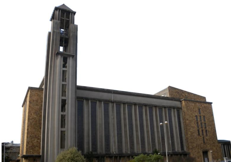
L'Eglise Saint-Louis à Brest reconstruite après la guerre où repose du Couëdic (doc Internet)
