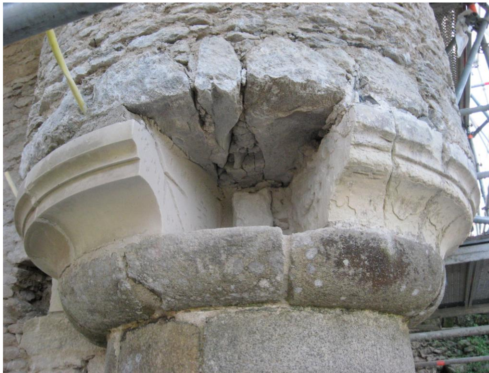
Taille de pierre et maçonnerie : interventions sur la base de la tourelle sud. A droite, les pierres de calcaire abîmées et en pendant les nouvelles. On notera la maçonnerie de moellons au-dessus destinée à être masquée par un enduit.
