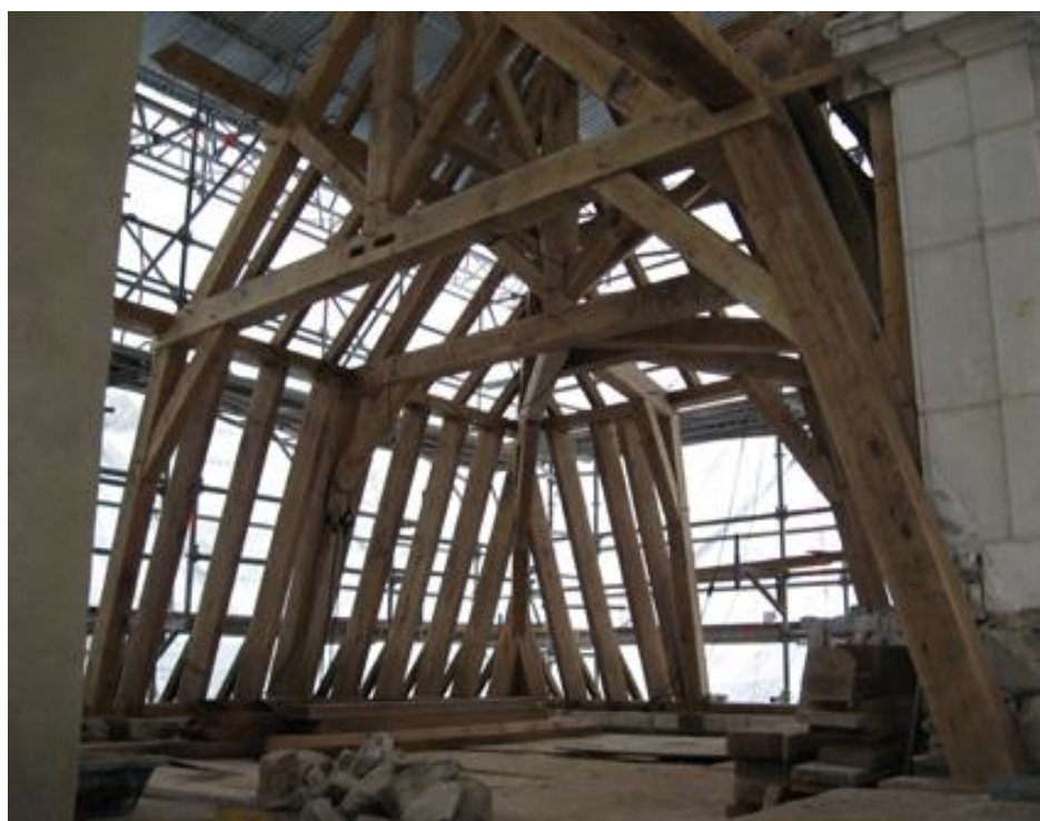
Charpente : vue sur la nouvelle charpente du corps principal du Pavillon Phot. Service valorisation du patrimoine – Ville d'Hennebont – Janvier 2009
