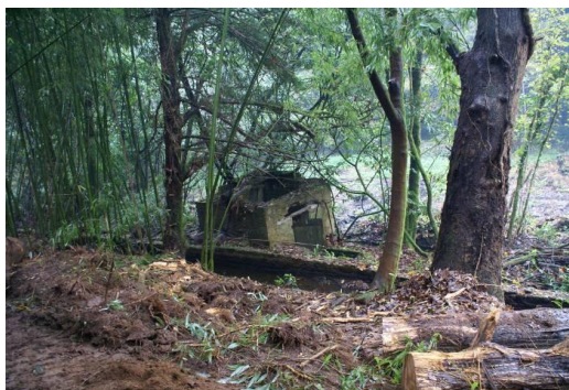
Canal avec la structure en pierre abritant le premier bélier hydraulique
