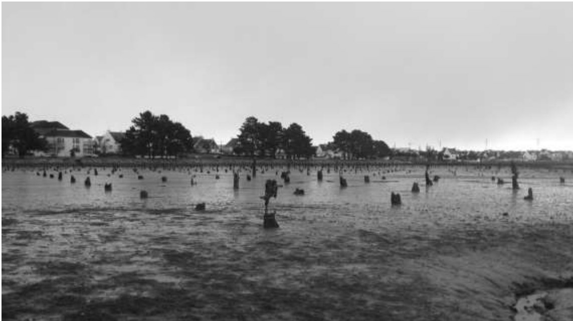
Vus du chenal du Scorff, les vestiges du parc de stockage du bois. Photo Claude Le Colleter
