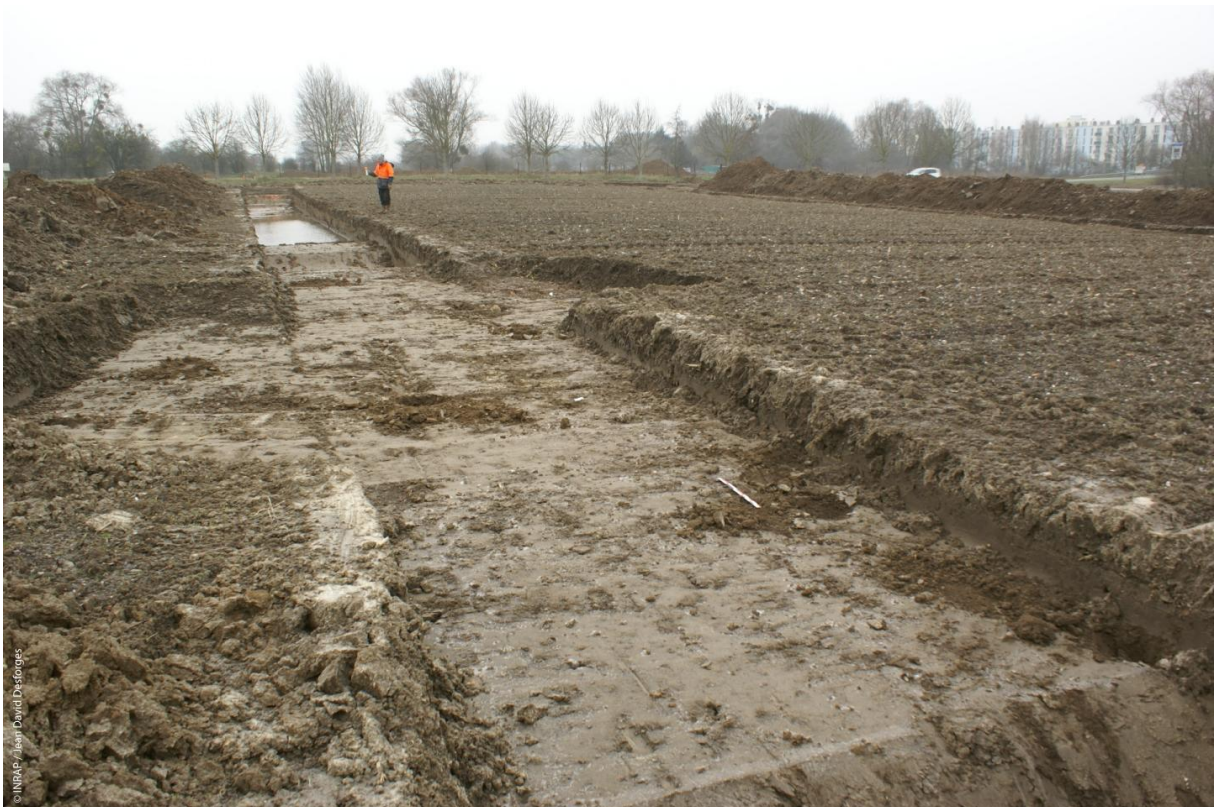
Fig. 3 : Dans la nuit du 8 au 9 février 2010, un chantier de diagnostic de l'INRAP à Noyon (60) a été visité par des utilisateurs de détecteurs de métaux. Ici, une tranchée qui a livré les fondations d'un bâtiment gallo-romain.
